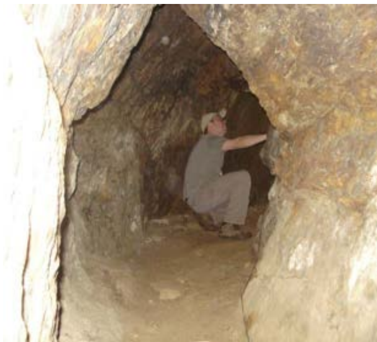
Foto nº 4b.21 - Túnel escavado em rocha destinado à adução de água para a mineração aurífera do período colonial.
