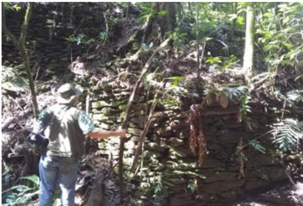
Foto nº 4b.07 - Contenção de encosta constituída de pedras secas, próximo à barragem do reservatório Ururuquara.
