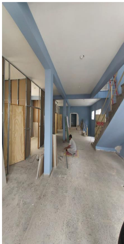
INSTALAÇÃO DE DRYWALL E PINTURA
