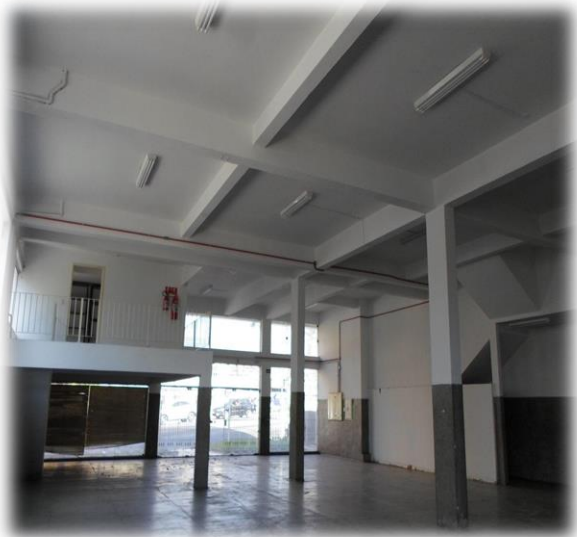
REFORMA EM ANDAMENTO
