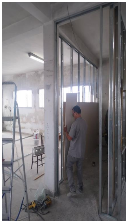
INSTALAÇÃO DE DRYWALL E PINTURA
