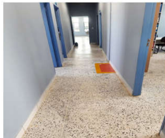
Foto 8: Administrativo 2º Pavimento
