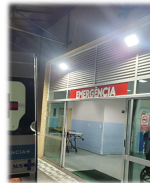
Instalação de Refletor
