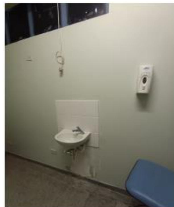
Foto 2. Lavatório do consultório.
