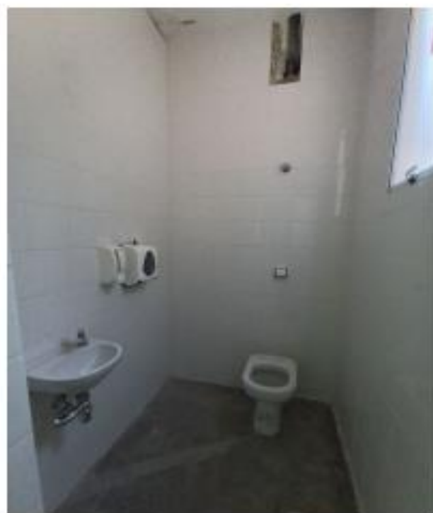
Foto 1. WC PNE da sala de USG.
