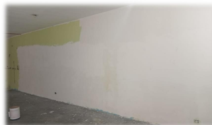
PREPARAÇÃO E LAVAGEM DA SALA DA FUTURA ADM, COPA, ALMOXARIFADO E ACS PARA RECEBER MASSA CORRIDA
