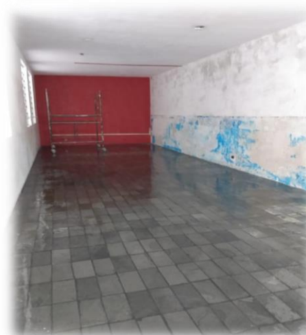
PREPARAÇÃO E LAVAGEM DA SALA DA FUTURA ADM, COPA, ALMOXARIFADO E ACS PARA RECEBER MASSA CORRIDA
