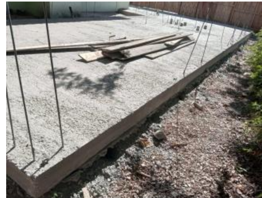
Fundação em radier concluída
