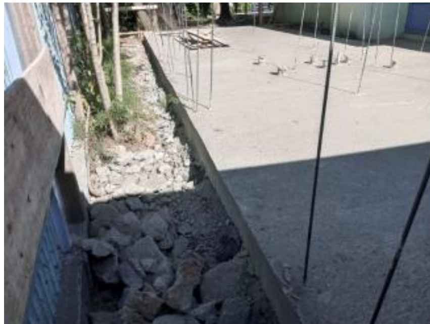
Fundação em radier concluída
