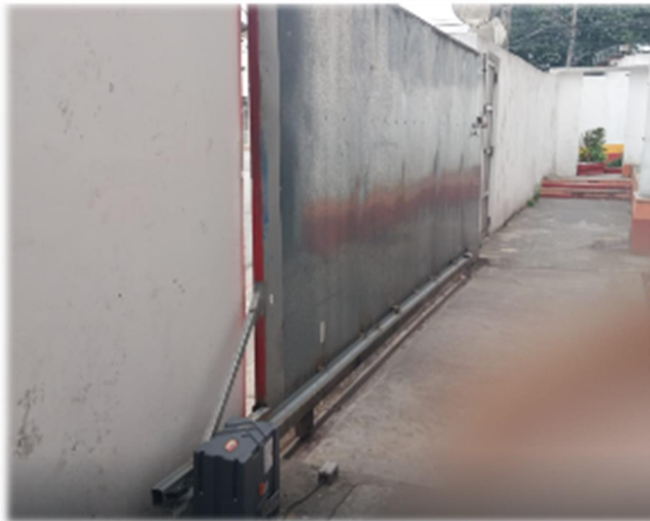
Automatização do Portão com Equipamentos Industriais – Base SAMU Cavadas
