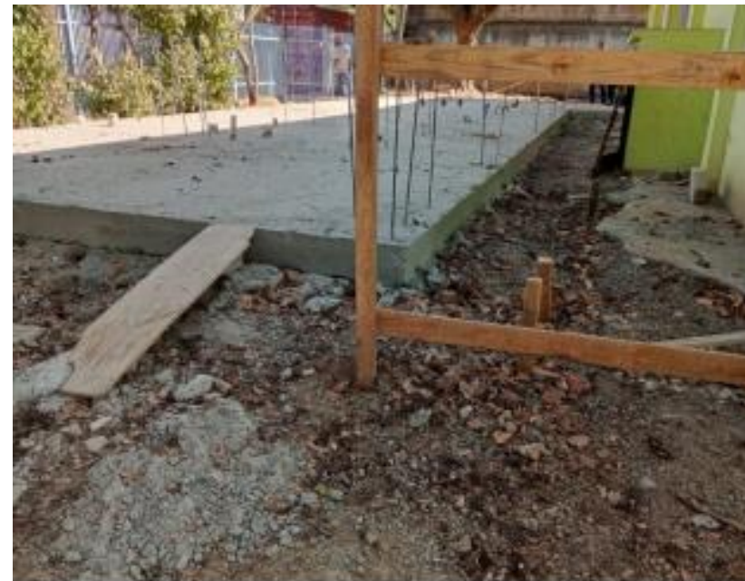
Fundação em radier concluída
