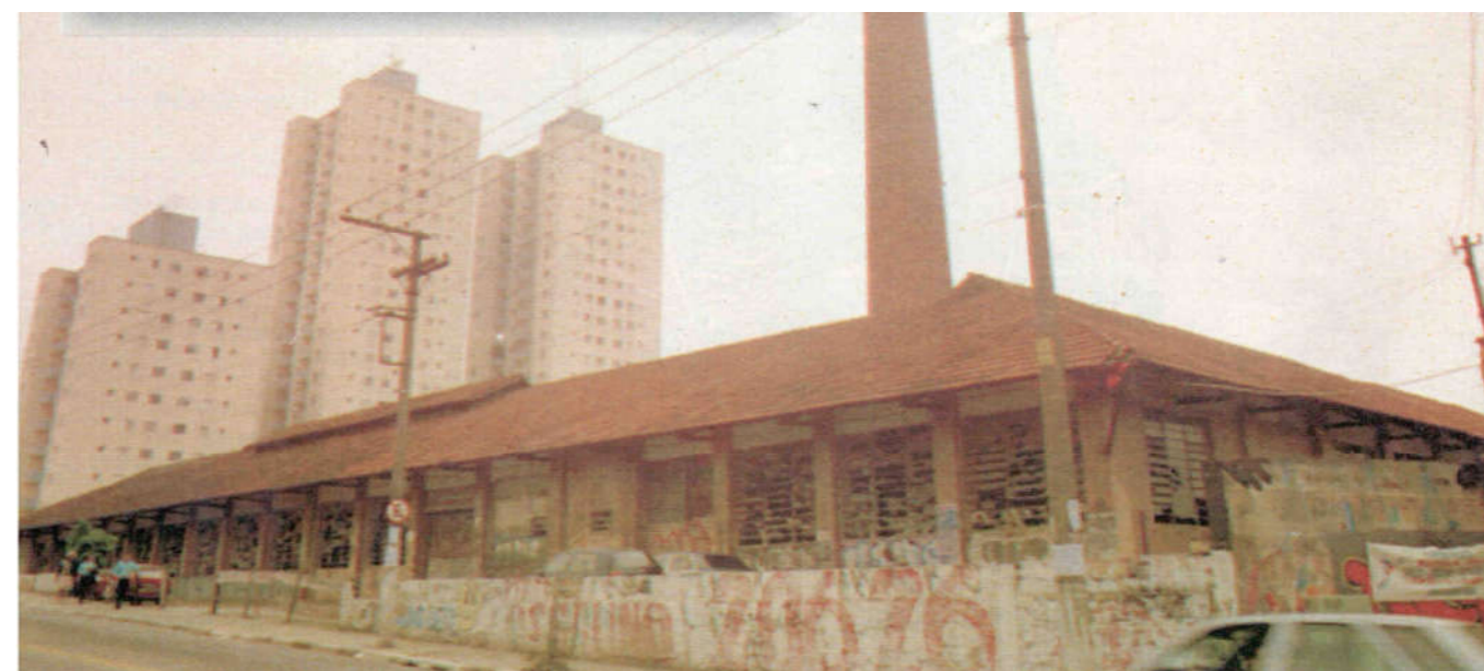
Figura 02. Foto do estado de abandono da Fábrica no início da década de 2000. Fonte: Arquivo Histórico de Guarulhos.
