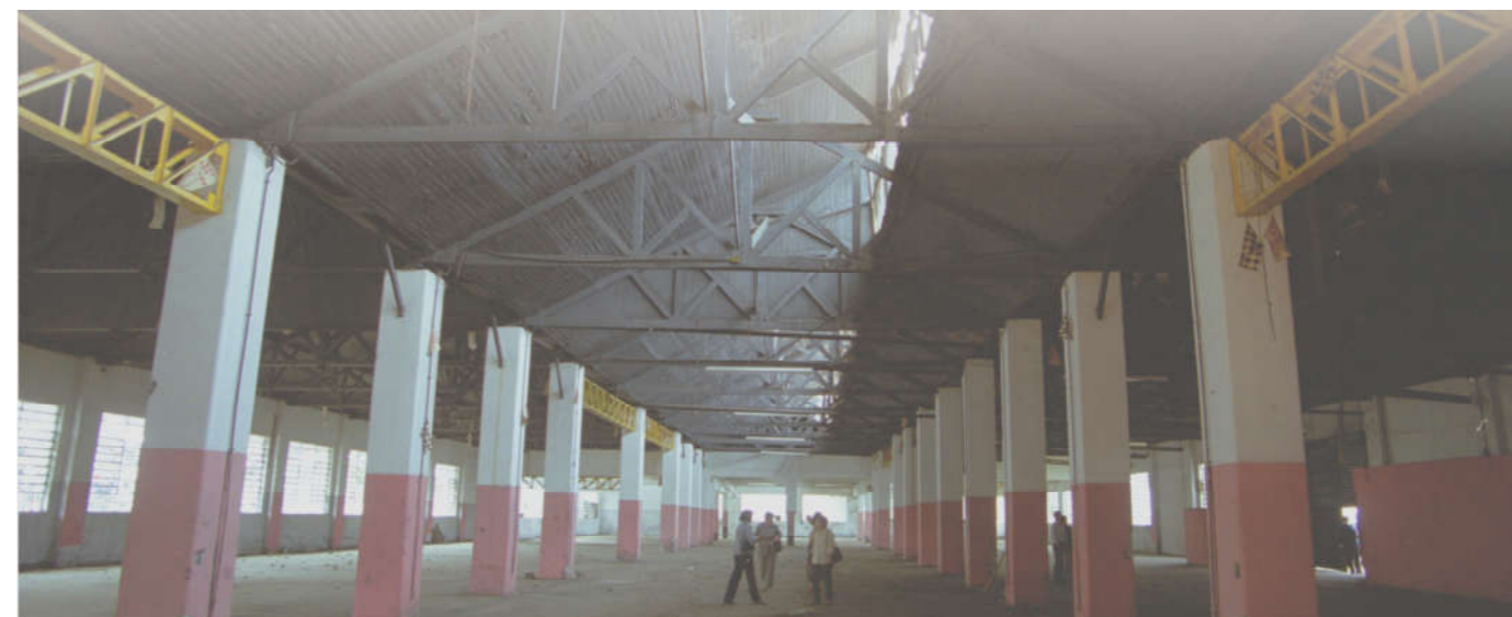
Figura 09. Foto de 2003, a partir da circulação central, com telhado tipo shed , no qual é possível observar os dois galpões principais, à direita e à esquerda, e a sequência de pilares. Fonte: Arquivo Histórico de Guarulhos.
