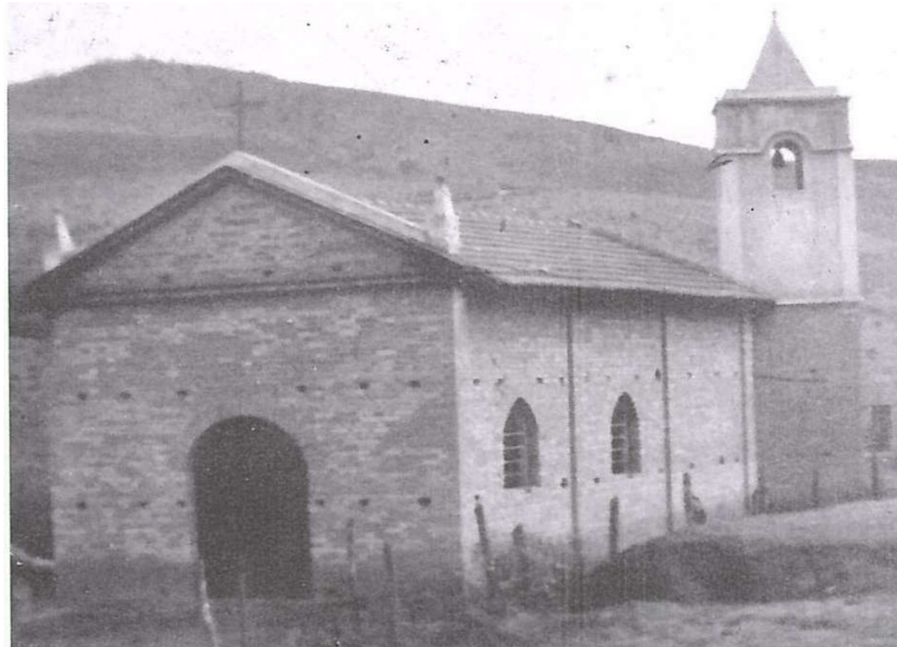
Figura 06. Foto da capela antes de receber o revestimento, data desconhecida. Fonte: Arquivo Histórico de Guarulhos.
