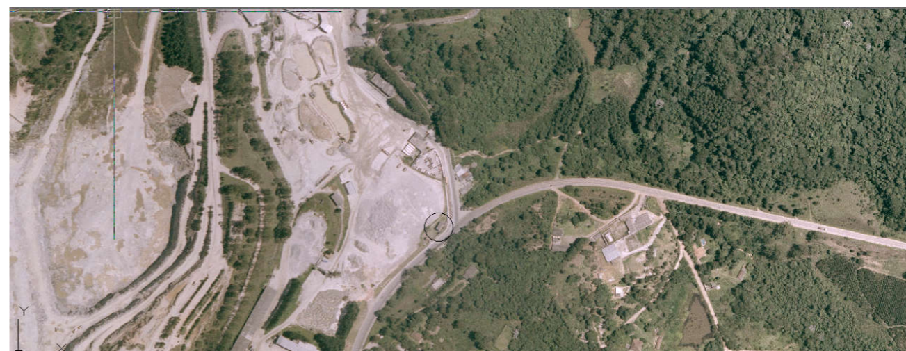
Figura 04. Levantamento aerofotogramétrico, 2008. Fonte: Prefeitura Municipal de Guarulhos.
