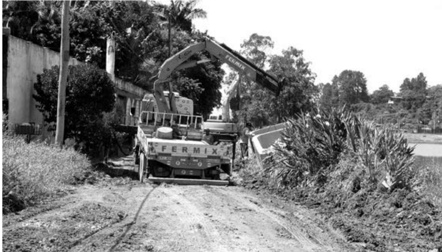
A avenida Miami está recebendo tubulações para o sistema de drenagem, a fim de resolver o problema de alagamento na área
